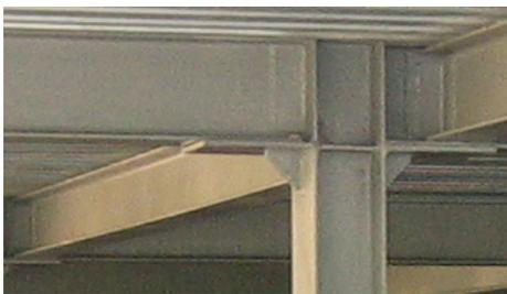
Рис. 5а. Сварные балочно-стоечные сопряжения
