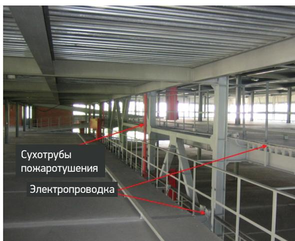
Рис. 10. Размещение инженерных коммуникаций и высота от пола до низа балки перекрытия.
