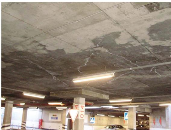
Рис. 12. Сквозные трещины в железобетонном перекрытии НМРА
